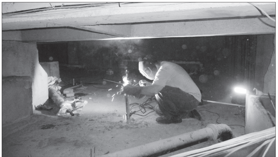
восстановление циркуляции ГВС Поморская д. 13
